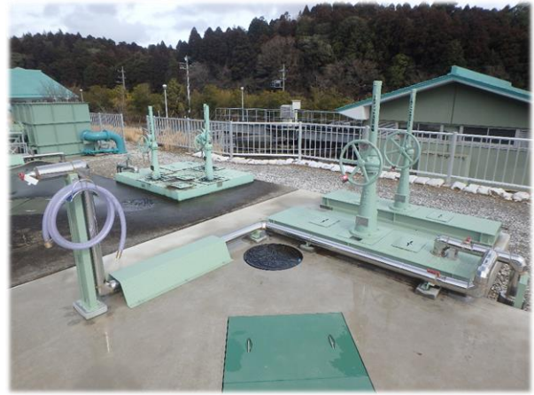
水処理設備放流ゲート完成時(機械工事)
