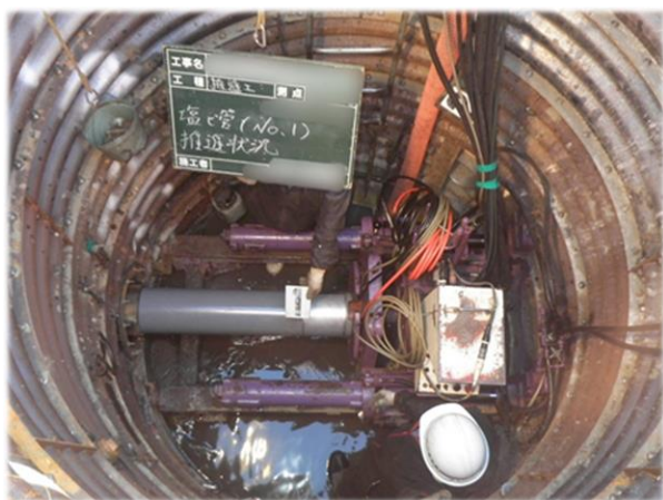
推進工法による汚水管布設状況(土木工事)
