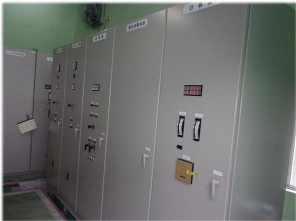
汚水ポンプ場の水位を確認する盤の更新、動作確認(電気工事)
