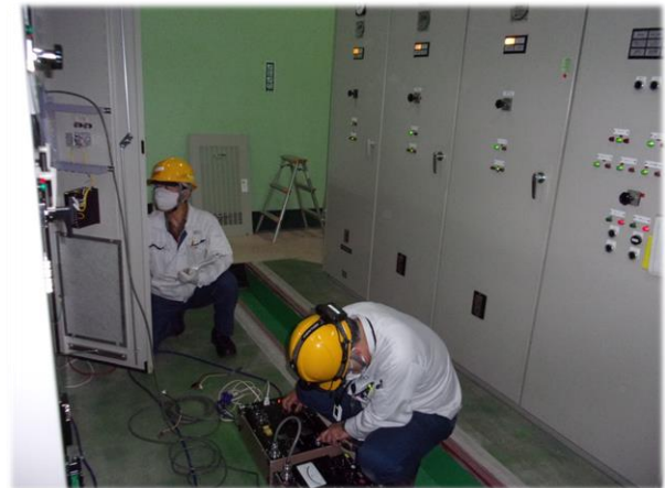
汚水ポンプ場の水位を確認する盤の更新、動作確認(電気工事)
