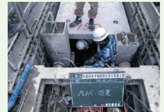
プレスバーの設置 ボックスカルバートにシールド機を押し出すためのプレスバーを設置します。
