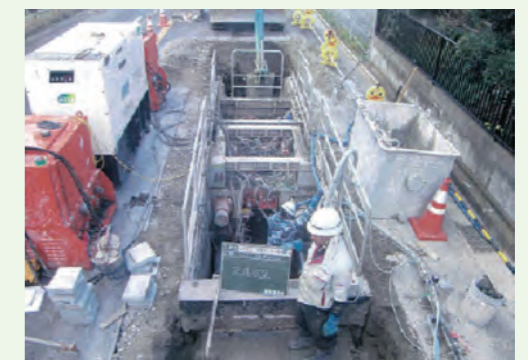
シールド機前進 シールド機のジャッキを伸ばしてプレスバーを押し、その反力でシールド機を前進させます。
