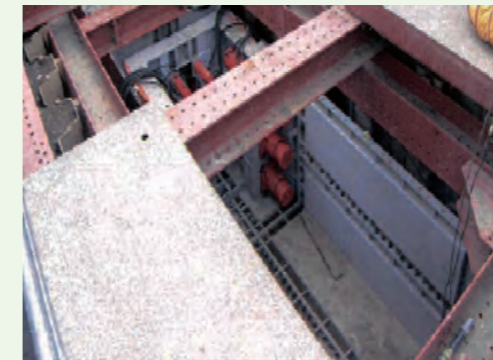
マシン組立 オープンシールド機組立完了です。
