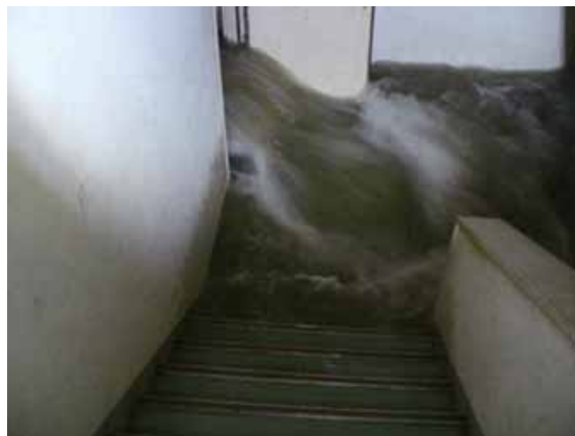
ポンプ場に流入する逆流水
