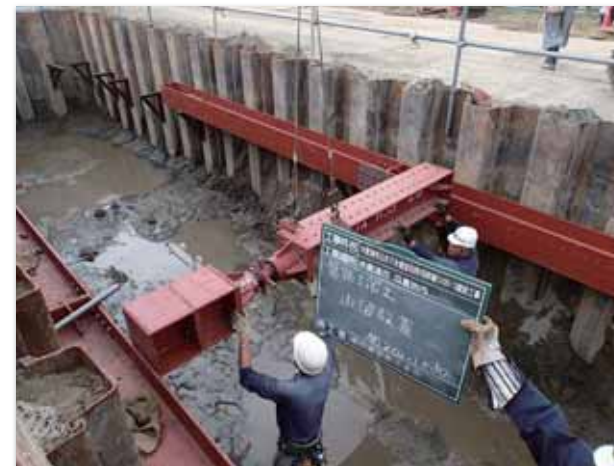
支保工の状況
