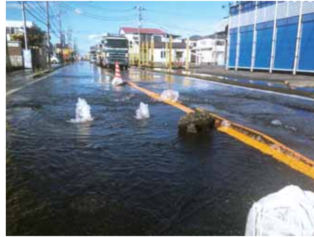
人孔からの溢水による舗装破損
