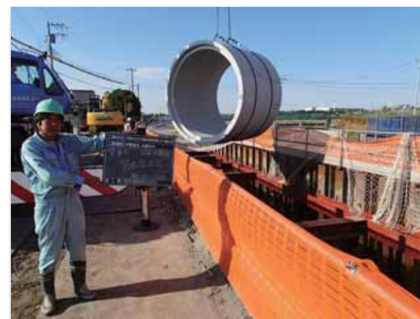
管渠つり込み状況
