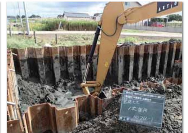
一次掘削状況
