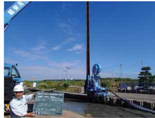
鋼矢板打設状況
