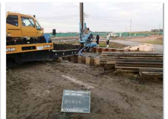
鋼矢板引抜状況
