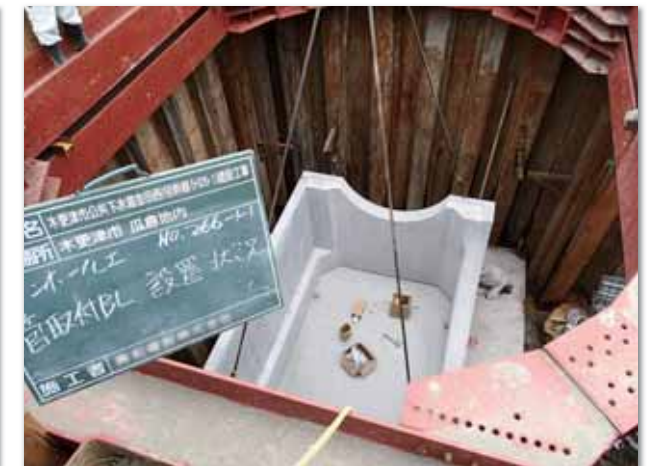
マンホール設置状況
