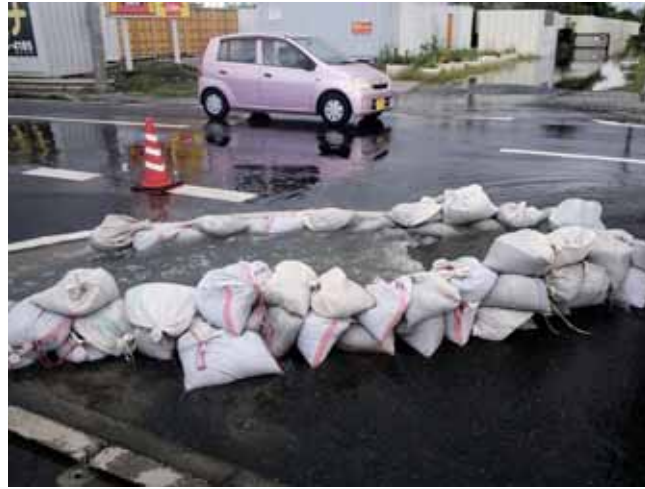
人孔からの溢水状況
