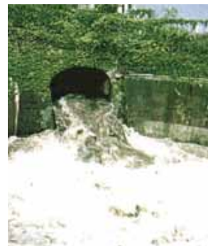
「写真1」雨水吐き室から河川等に流出する合流式下水道
