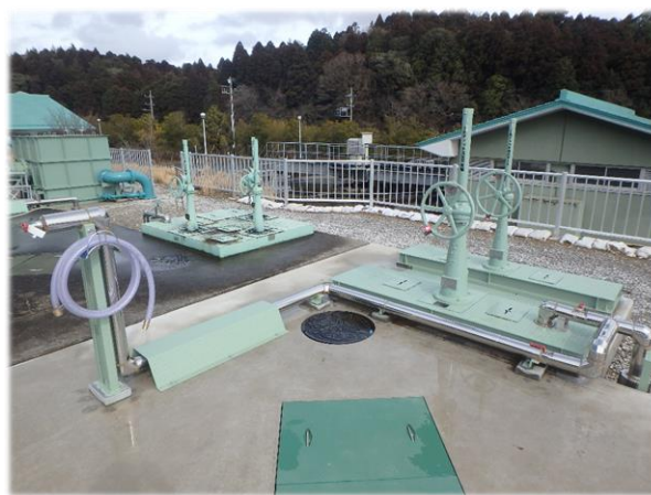
水処理設備放流ゲート完成時(機械工事)
